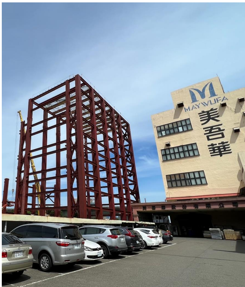
自動倉儲鋼構建築結構完工(1H/2022)
